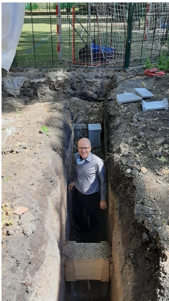
Kontrola, zda jsou základy stavby dostatečně hluboké.
