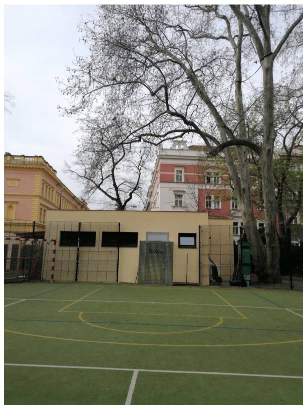
Pod střechu sportovního domečku ukryl před dokončením pan správce Pechr schránku s materiály z dnešní doby - například peníze a noviny, tak snad stavba dlouho vydrží a bude to za 100 let zajímavý nález.
